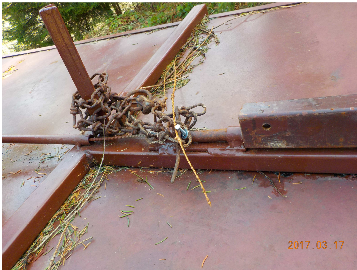
Rysunek 7. Bolec zwalniający klapę – zapadnię.
